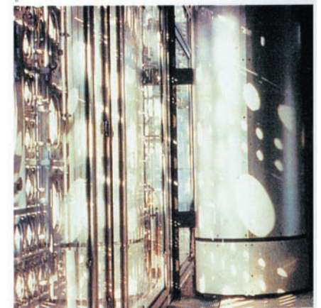
The shutter system of Jean Nouvel's Institut du Monde Arab (Behling, 1996, 217)
